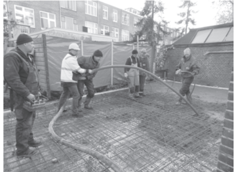
Het storten van de vloer is begonnen
