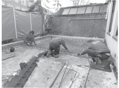
De wapening voor de betonvloer wordt aangebracht. Eén van de wapeningsvlechters bleek nog aardig orgel te spelen ook en begeleidde de mannen tijdens de pauzes met orgelmuziek.
