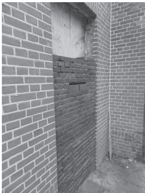
De vroegere zijdeur wordt dichtgemetseld. Hier wordt op 22 december 2013 aan de binnenzijde de eerste steen geplaatst. Aan de buitenzijde is een uitsparing vrijgehouden, waarin een loden koker met de oorkonde wordt geplaatst.
