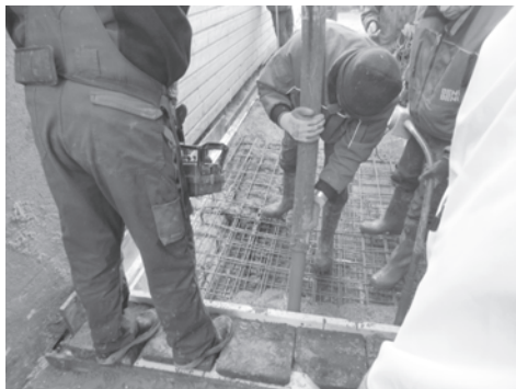
Een mooi hoogtepunt: het laatste stuk van de betonvloer wordt gestort!
