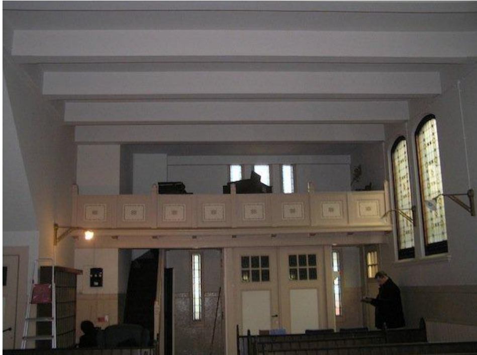
De tegenwoordige dagkapel was een donkere hal, met daarboven een orgelgalerij. Weet u waar deuren nu zijn?
