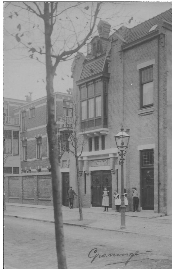
De Katholiek Apostolische kerk niet lang na de bouw in 1917.
